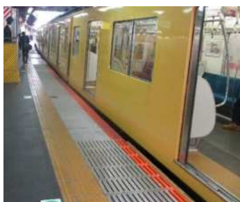
安全対策状況(内方線つき点状ブロック、転落防止ゴム、CPライン)
