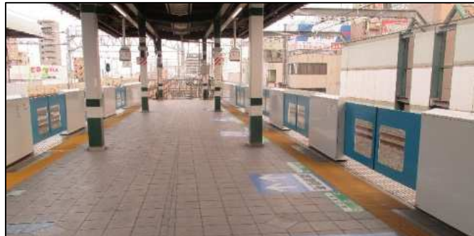
練馬駅ホームドア設置状況
