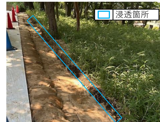
写真1 雨水浸透施設（施工後）
