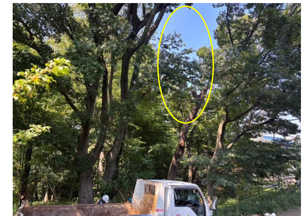
写真2 枝落とし（施工後）
